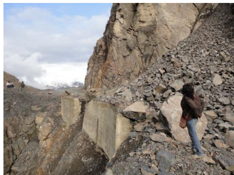
Foto 6. Proceso de caída de rocas. Carretera de Santillana. Octubre de 2010
