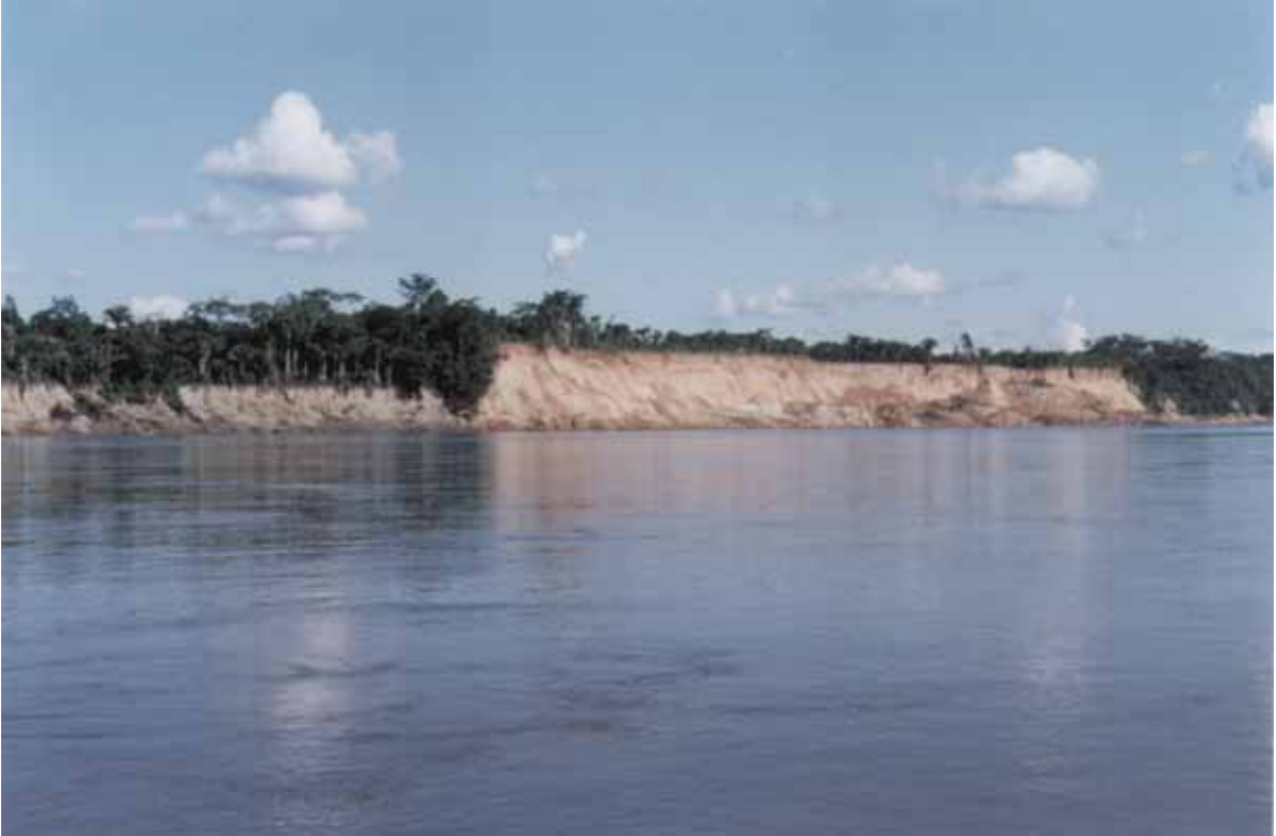
Problemas de erosión lateral en el río Madre de Dios
