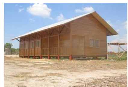
Aula unidocente de madera terminada
