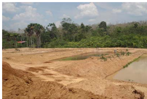
Ampliación de las instalaciones de la estación de investigación El Castañal, Madre de Dios
