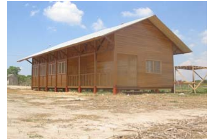
Aula unidocente de madera terminada
