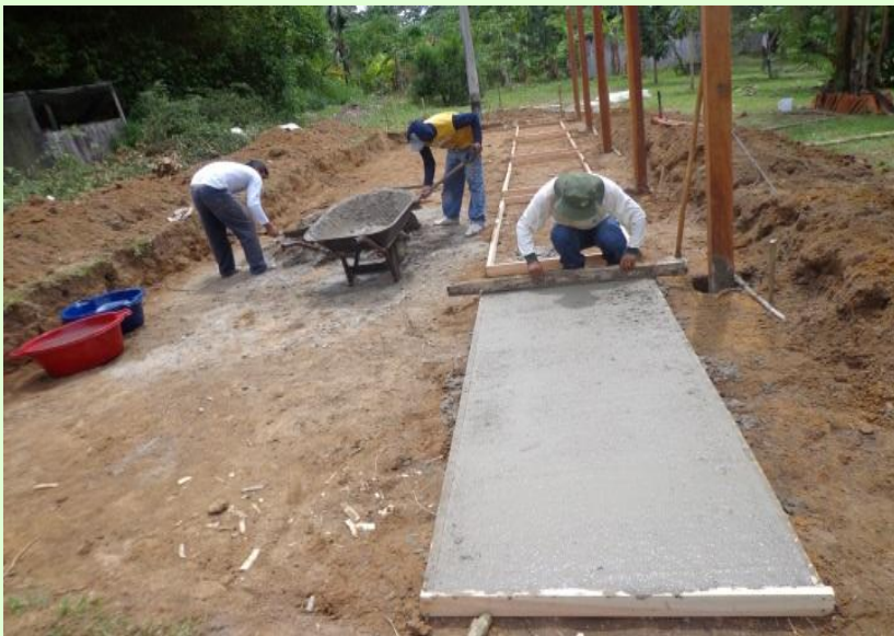
Construcción de piso de cemento para las cámaras
