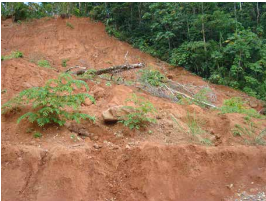
Foto 13: Erosión por deslizamiento que la estabilidad de la infraestructura de carreteras. Cercanías de Salvación.
