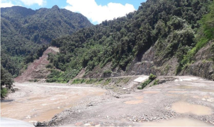
**Figura 14.** Carretera en el tramo Boquerón -Previsto, afectado por el proceso de inundación.
