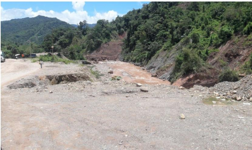
**Figura 28.** Carretera Federico Basadre en riesgo potencial por erosión lateral (tramo-Boquerón-Previsto).
